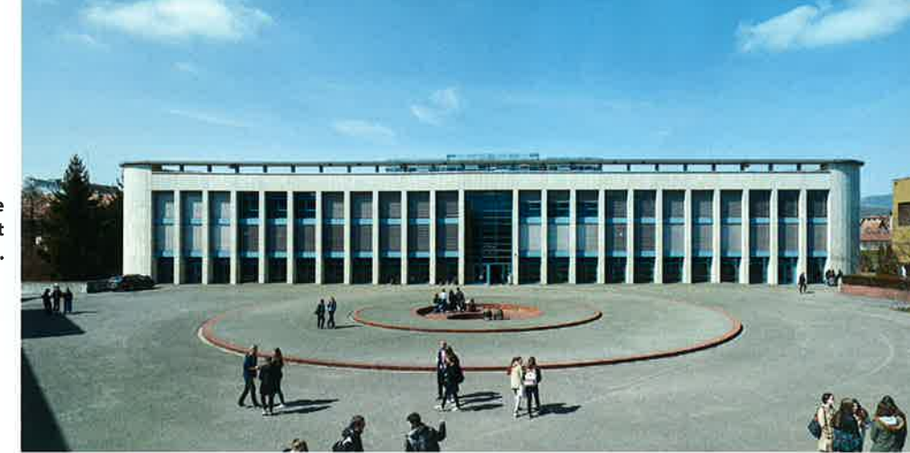
Vue de la barre horizontale du T que forme le collège construit dans les années 1990.
